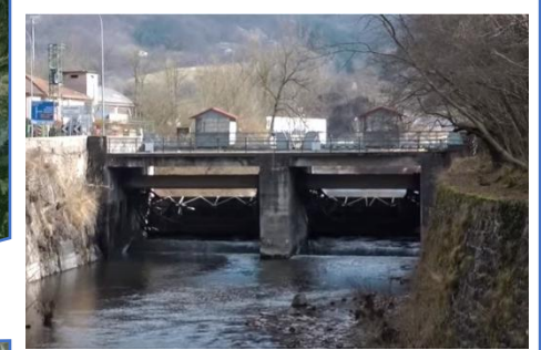
Diga del lago d'Idro
